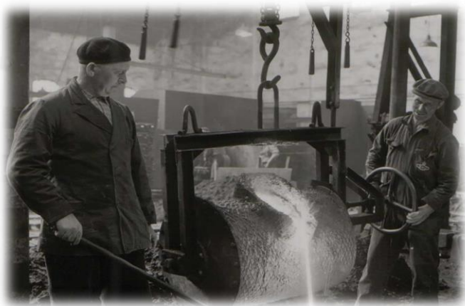
Arbeiders in de Keppelse IJzergieterij
