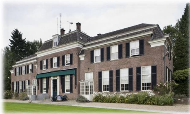
Het tuinhuis van Kasteel Enghuizen ('de Orangerie')
